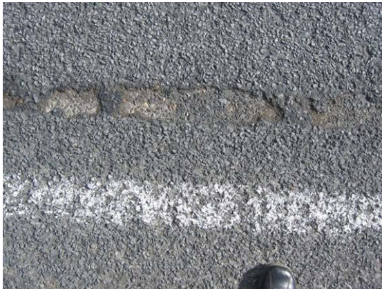
Mynd A1: Klæðing losnar af gamalli kantmálningu.
